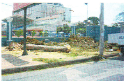
HCMC市内 倒れた街路樹の撤去の様子
